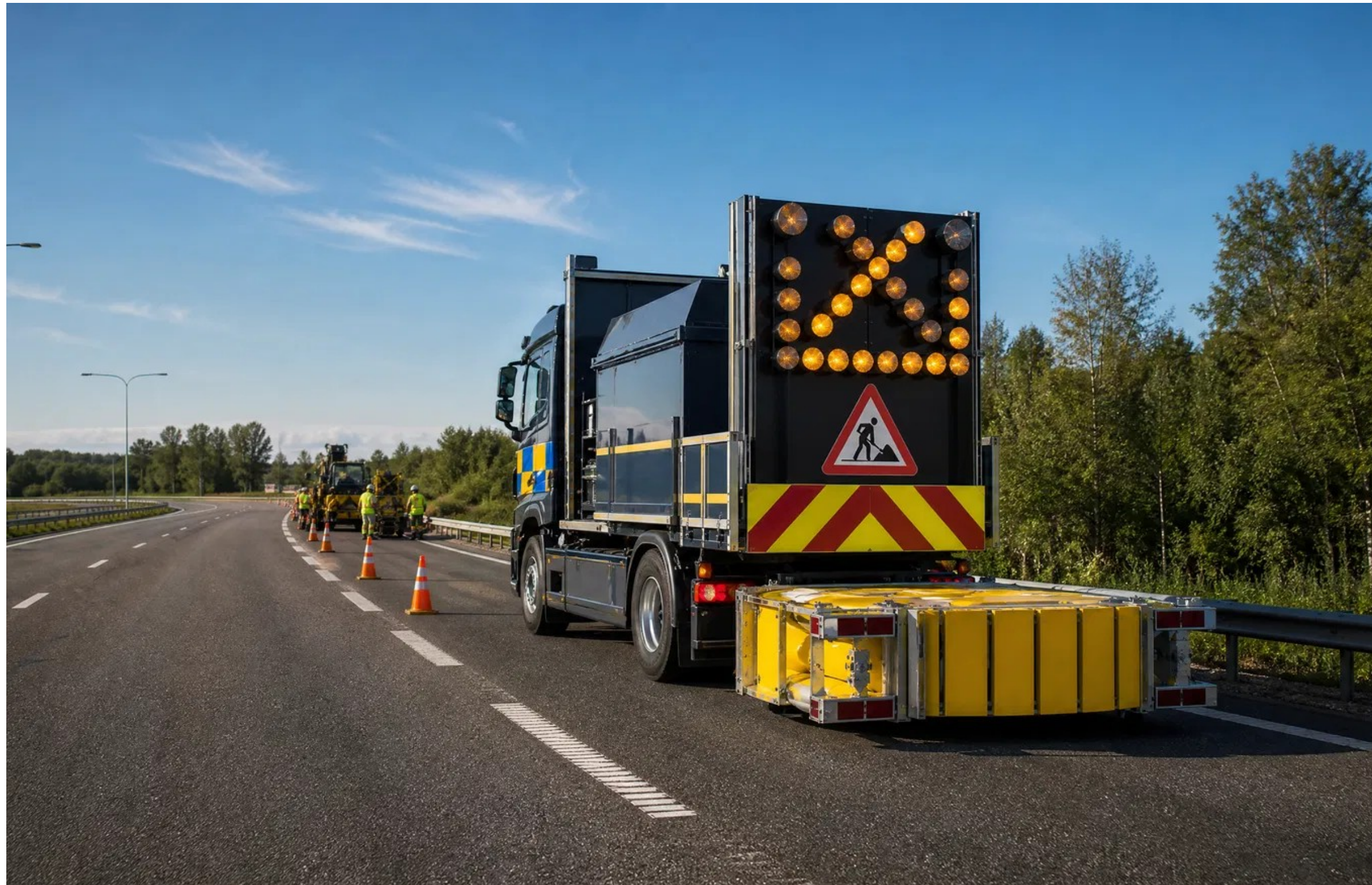
Ur Modul 2: TMA-skyddat vägarbete.
